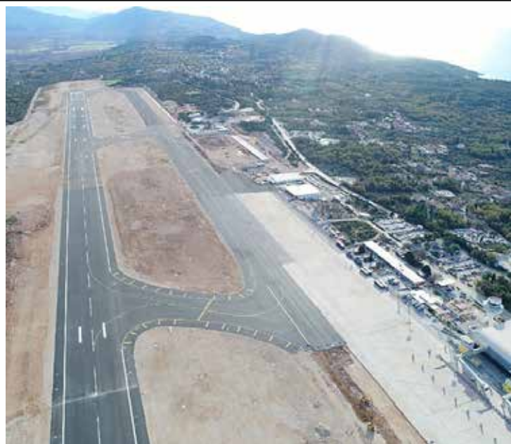
SANACIJA 2/3 FAZA 3 A i B
